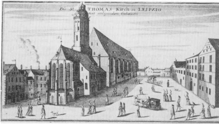
Chiesa di San Tommaso ed edifici adiacenti: Amthaus (1), Consistorium (2) e casa parrocchiale (3).
